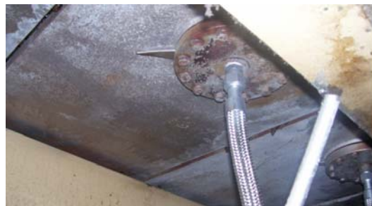
รูปที่ 5.6 Hot plate ซึ่งพื้นที่ด้านล่างไม่มีการหุ้มฉนวนกันความร้อน
