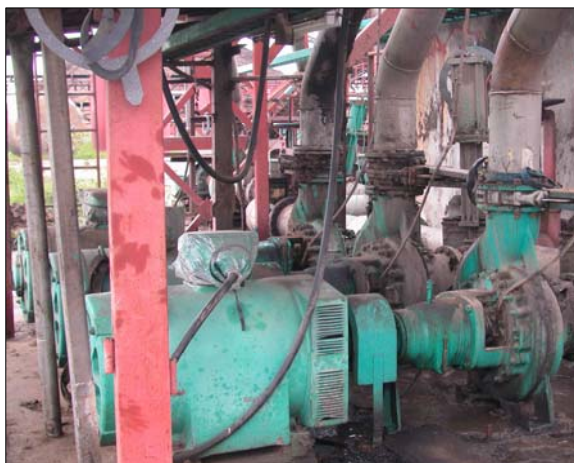
รูปที่ 5.3 ปัมพ์ขนถ่ายขานอ้อยในการล้างทำความสะอาด (Hydra pulper pump)
